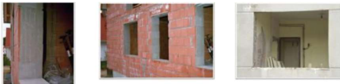
Slika 7.2 - 1 Priprema građevinskog otvora za RAL montažu
